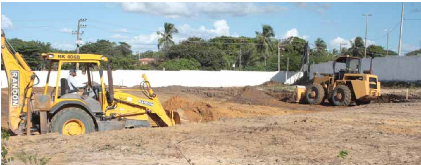
Tratores fazem o nivelamento do terreno onde está sendo executada a segunda etapa de obras
